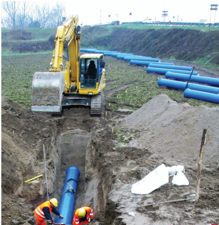
(Lavori idrici lungo SR 10/SP 91 in Comune di Este - PD)
