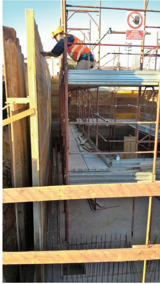
(Realizzazione impianto di in Comune depurazione di Orgiano – VI)
