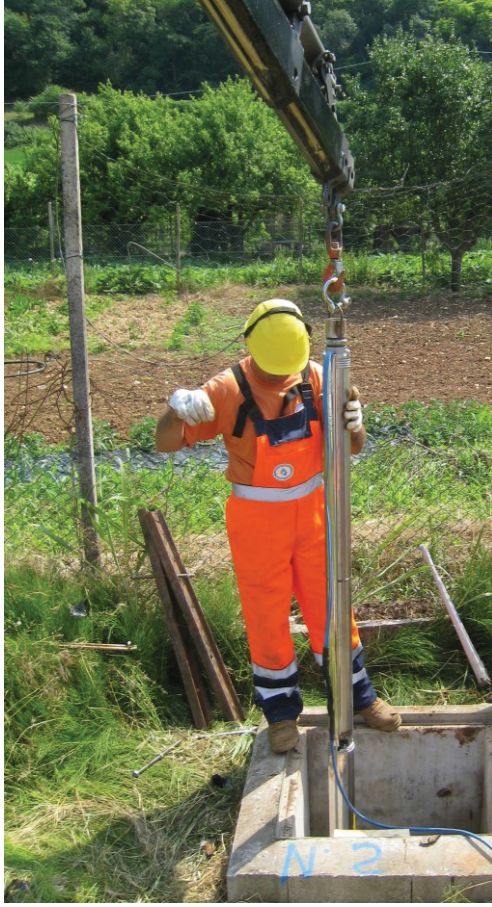
(Sostituzione pompa pozzo Vigazzola di San Germano dei Berici - VI)
