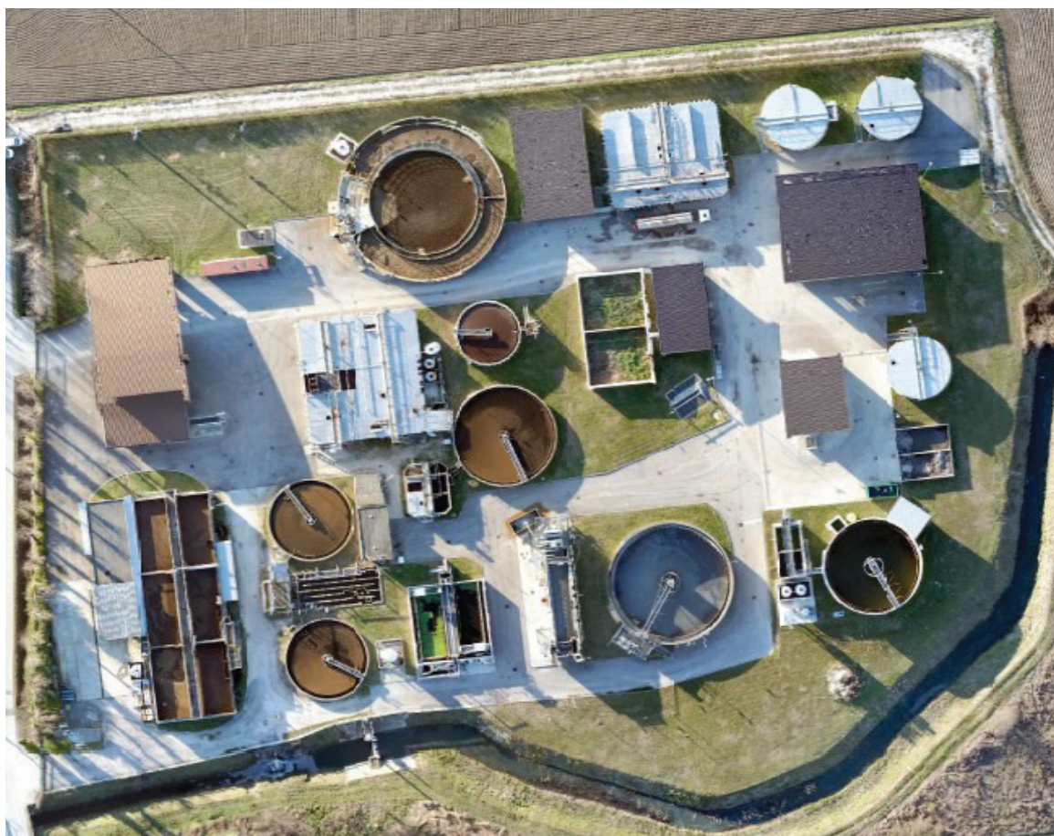
(Impianto di depurazione di Via Del Borgo in Comune di Monselice – volo drone febbraio 2016)
